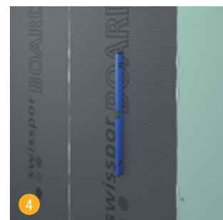
4 Aligner tous les panneaux de construction swissporBOARD de manière homogène les uns par rapport aux autres sur l'ossature ou directement sur le mur.
