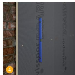
4 Aligner tous les panneaux de construction swissporBOARD de manière homogène les uns par rapport aux autres.
