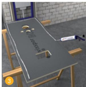
3 Coller le panneau de bâti-support swissporBOARD sur l'ossature avec le mastic et colle hybride swissporBOARD SB 911.
