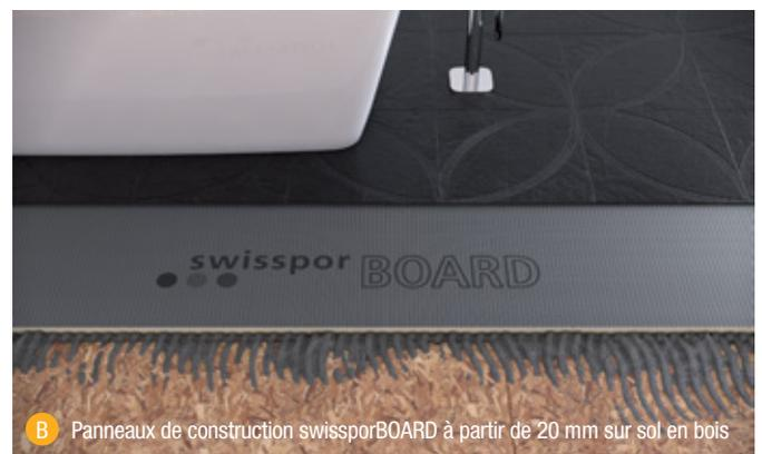
B Panneaux de construction swissporBOARD à partir de 20 mm sur sol en bois
