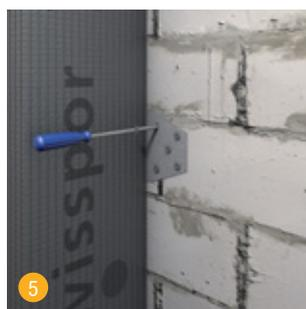
5 Visser l'élément d'angle en L swissporBOARD sur le support.
