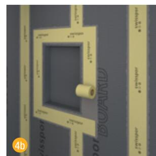
4b Étancher tous les bords à souder dans la zone humide avec la bande d'étanchéité swissporBOARD et le mastic flexible 1K rapide swissporBOARD / mastic flexible Turbo 2K.
