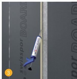
3 Le mastic d'étanchéité et colle hybride swissporBOARD SB 911 permet de coller et de sceller les arêtes du bord à souder.
