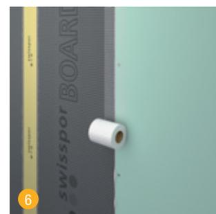
6 En dehors de la zone humide, fixer les arêtes du bord à souder avec la bande de renfort SK swissporBOARD (autocollante).
