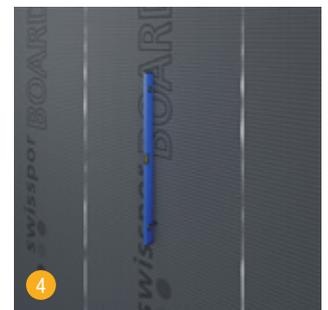
4 Aligner tous les panneaux de construction swissporBOARD de manière homogène les uns par rapport aux autres.
