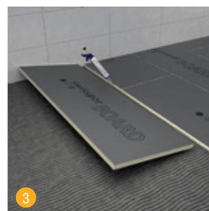
3 Coller les panneaux de construction swissporBOARD à partir de 20 mm sur le support et appliquer le mastic d'étanchéité et colle hybride swissporBOARD SB 911 sur les arêtes du bord à souder.
