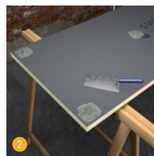
2 Appliquer ensuite rapidement des bouchons de mortier à partir de la colle flexible S1/S1 swissporBOARD sur les ouvertures.
