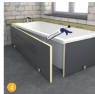
4 Coller et étancher tous les joints avec la colle et le mastic d'étanchéité hybride swissporBOARD SB 911.
