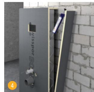
4 Fixer les bandes découpées du panneau de bâti-support swissporBOARD en haut et sur le côté avec le mastic d'étanchéité et colle hybride swissporBOARD SB 911.
