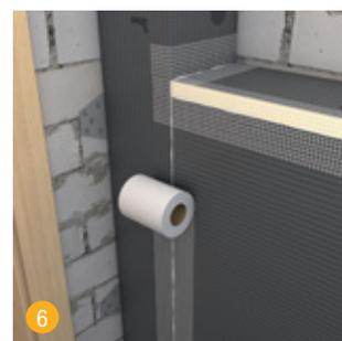
6 Doter toutes les arêtes du bord à souder avec du mastic d'étanchéité et colle hybride swissporBOARD SB 911 et une bande de renfort SK swissporBOARD (autocollante). Dans les zones humides, les joints doivent être étanchés avec la bande d'étanchéité swissporBOARD.
