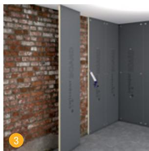
3 Coller et sceller les arêtes du bord à souder les unes aux autres à l'aide du mastic et colle d'étanchéité hybride swissporBOARD SB 911.
