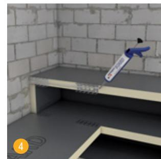
4 Coller et sceller toutes les arêtes du bord à souder les unes aux autres à l'aide du mastic d'étanchéité et colle hybride swissporBOARD SB 911.
