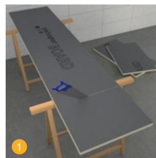
1 Couper les panneaux de construction swissporBOARD à partir de 20 mm avec une scie.
