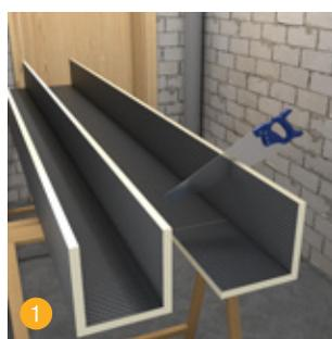
1 Scier l'élément d'angle en U ou L swissporBOARD selon les dimensions souhaitées.
