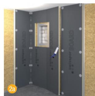
2a Coller les panneaux de construction swissporBOARD sur l'ossature avec le mastic d'étanchéité et colle hybride swissporBOARD SB 911 et les visser.
