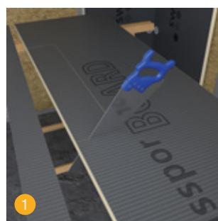
1 Couper les panneaux de construction swissporBOARD et scier un évidement pour la swissporBOARD Nicchia si nécessaire.
