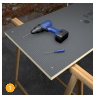
1 Pour la fixation ultérieure, de petits trous sont percés ou piqués sur le panneau de construction swissporBOARD (5 par m<sup>2</sup>).
