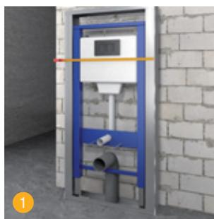
1 Monter et mesurer l'élément de bâti-support et l'ossature.
