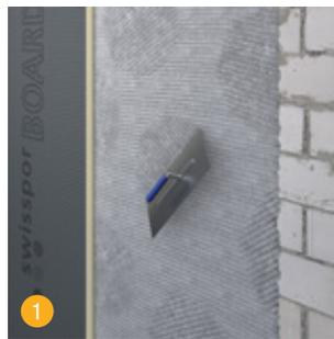
1 Sur les supports plans, appliquer rapidement et uniformément la colle flexible swissporBOARD S1 à l'aide d'une truelle dentée.
