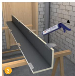
3 Doter les arêtes du bord à souder de l'élément d'angle en L swissporBOARD avec du mastic d'étanchéité et colle hybride swissporBOARD SB 911.
