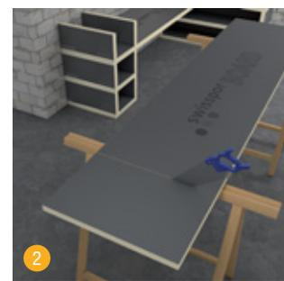
2 Tous les panneaux de construction swissporBOARD peuvent être coupés facilement sur mesure.
