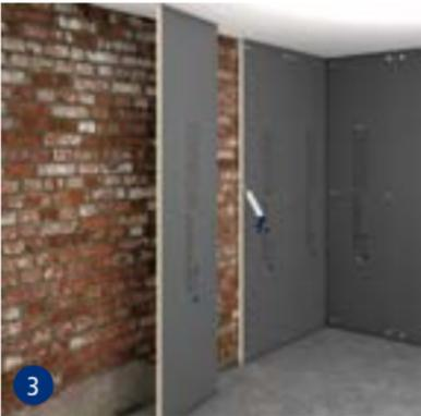
3 Mittels swissporBOARD Hybrid Kleb- und Dichtstoff die Stoßkanten miteinander verkleben und abdichten.
