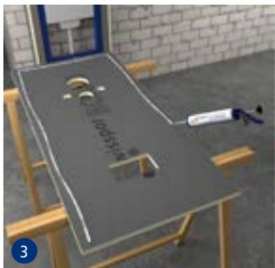
3 swissporBOARD Vorwandplatte mit swissporBOARD Hybrid Kleb- und Dichtstoff auf dem Ständerwerk verkleben.
