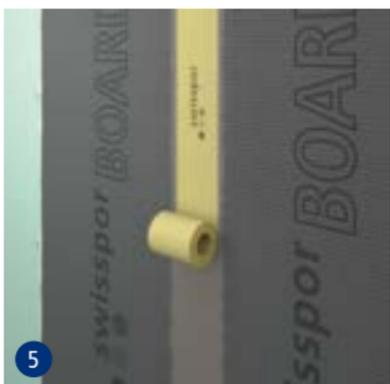
Das swissporBOARD Spezial-Dichtband dichtet die Stöße für den Nassbereich ab und wird mit swissporBOARD Flexdicht 1K/Flexdicht Turbo 2K aufgebracht.
