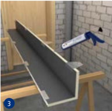
Stoßkanten des swissporBOARD Winkellements mit swissporBOARD Hybrid Kleb- und Dichtstoff versehen.
