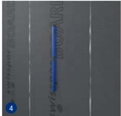
4 Alle swissporBOARD Bauplatten gleichmäßig zueinander ausrichten.
