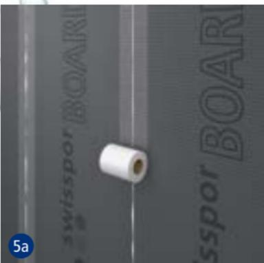
5a Die Bauplattenstöße mit dem swissporBOARD Armierband (selbstklebend) fixieren.
