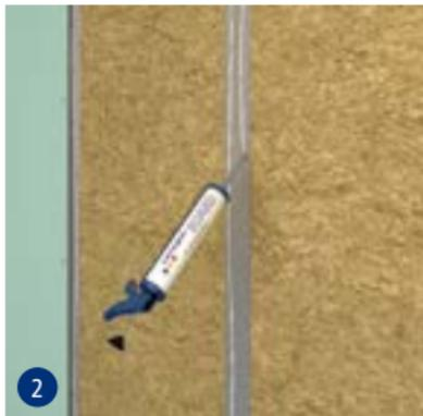
Mit swissporBOARD Hybrid Kleb- und Dichtstoff lassen sich die swissporBOARD Bauplatten auf jedem Ständerwerk verkleben.
