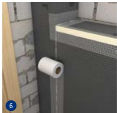
Alle Stoßkanten mit swissporBOARD Hybrid Kleb- und Dichtstoff sowie swissporBOARD Armierband (selbstklebend) versehen.
