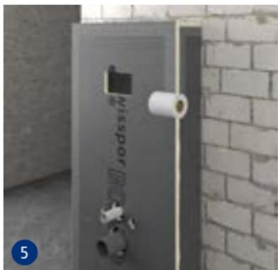
5 Alle Stoß- und Anschlussbereiche mit swissporBOARD Armierband (selbstklebend) versehen.
