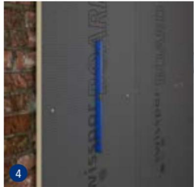
4 Alle swissporBOARD Bauplatten gleichmäßig zueinander ausrichten.
