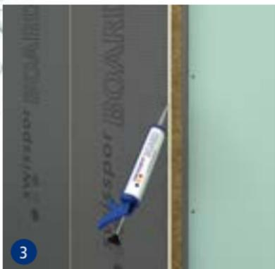
Ebenfalls mit swissporBOARD Hybrid Kleb- und Dichtstoff die Stoßkanten verkleben und abdichten.
