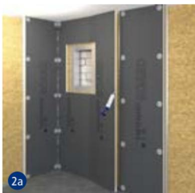
swissporBOARD Bauplatten mit swissporBOARD Kleb- und Dichtstoff auf dem Ständerwerk verkleben und festschrauben.
