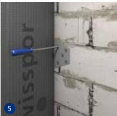
Das swissporBOARD Winkelement mit dem Untergrund verschrauben.
