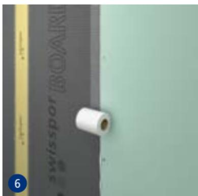
Außerhalb des Nassbereichs Stoßkanten mit swissporBOARD Armierband (selbstklebend) fixieren.
