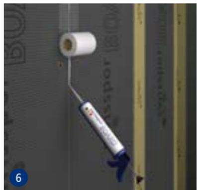
6 Bauplattenstöße mit swissporBOARD Armierband (selbstklebend) fixieren. Im Nassbereich mit swissporBOARD Spezial-Dichtband und swissporBOARD Flexdicht 1K/Flexdicht Turbo 2K abdichten.
