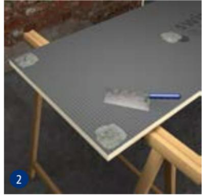
2 Anschließend Mörtelbatzen aus dem swissporBOARD Flexkleber S1 auf die Öffnungen aufbringen.
