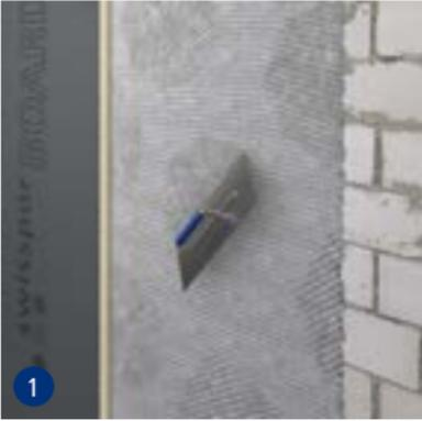
1 Auf den ebenen Untergründen den swissporBOARD Flexkleber S1 mit einer Zahnkelle gleichmäßig auftragen.
