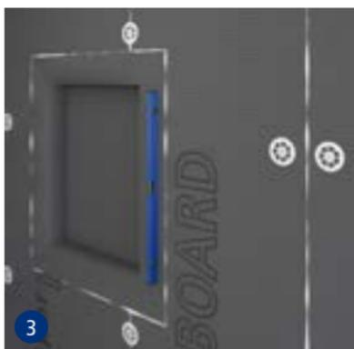
Alle swissporBOARD Bauplatten gleichmäßig zueinander ausrichten.
