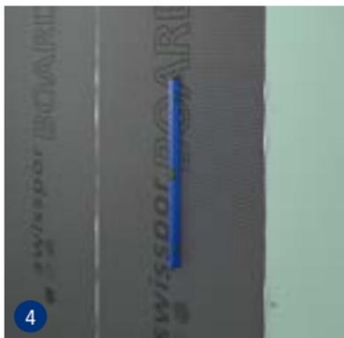
Ob auf Ständerwerk oder direkt auf der Wand, alle swissporBOARD Bauplatten gleichmäßig zueinander ausrichten.
