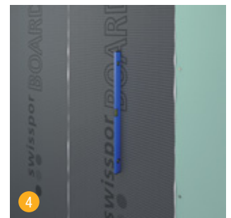
Ob auf Ständerwerk oder direkt auf der Wand, alle swissporBOARD Bauplatten gleichmäßig zueinander ausrichten.
