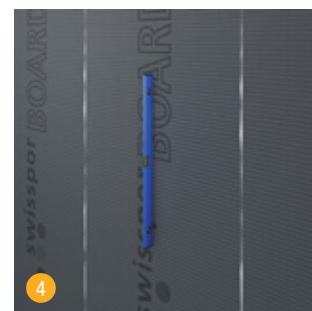
4 Alle swissporBOARD Bauplatten gleichmäßig zueinander ausrichten.
