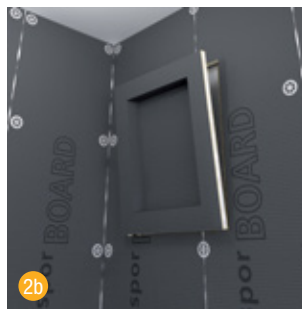
2b Optional zusätzlich die swissporBOARD Nicchia mit Bauplatte und Ständerwerk verkleben und festschrauben.
