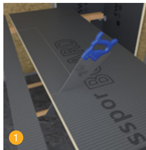
1 swissporBOARD Bauplatten zuschneiden und bei Bedarf Aussparung für die swissporBOARD Nicchia aussägen.
