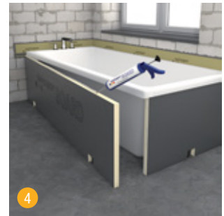
4 Alle Stoßkanten mit swissporBOARD SB 911 Hybrid Kleb- und Dichtstoff verkleben und abdichten.
